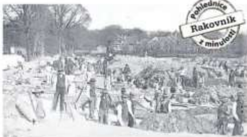
KOPÁNÍ ZEMĚDÍ u sokolovny v Rakovnicku v roce 1953. Foto: archiv Sokolů T.Š.Š. Hradec
