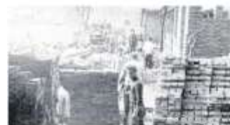
STAVBA SOKOLOVNY v Rakovnicku v roce 1953. Foto: archiv Sokolů T.Š.Š. Hradec
